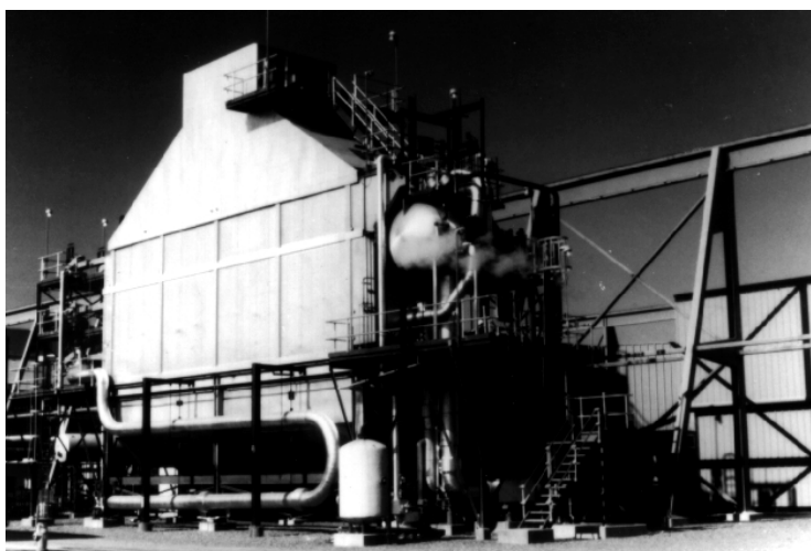
Figure 25. Forced-circulation HRSG with PG7111EA gas turbines
